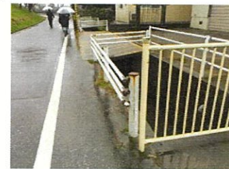
防護柵(ガードパイプ)修繕 (金沢市)
