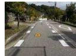
「速度落せ」の路面標示の設置
