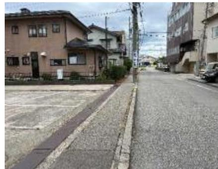
側溝の蓋を鉄板からコンクリートに変更（市）
