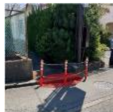
グレーチングの設置を検討(学校)
